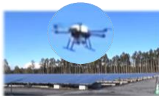
太陽光パネル
